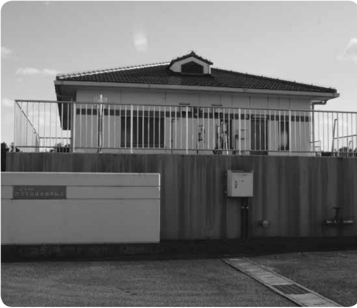
農業集落排水処理施設(寺崎)
