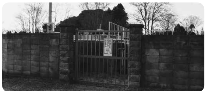
むつみニュータウン汚水処理施設
